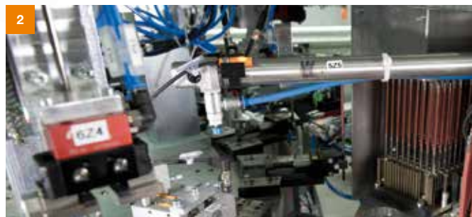
Avvio del processo di produzione interamente automatizzato: l'installazione del riscaldatore e della sua prolunga...
